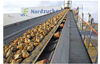
ABB. 9 Förderbänder befördern die auf dem Feld vorgewaschenen Rüben in die Waschanlage. Foto: Nordzucker AG
